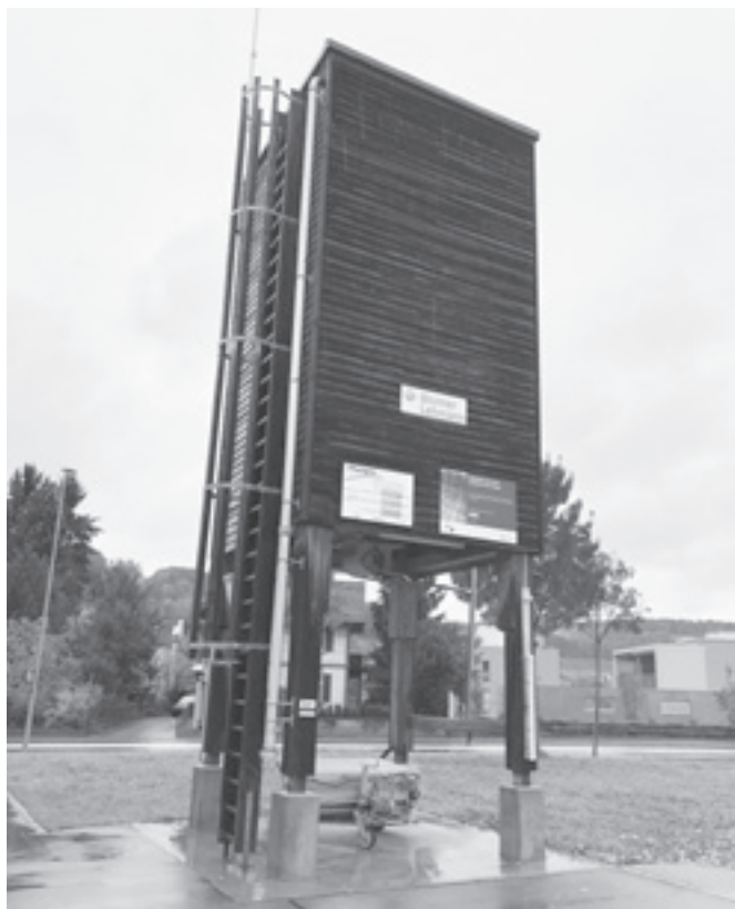
Salzsilo mit 50 m3 Fassungsvermögen
