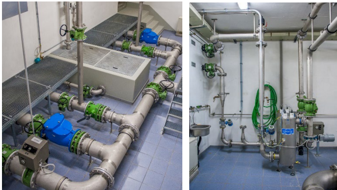
Inneres des Wasserreservoirs Grabi
