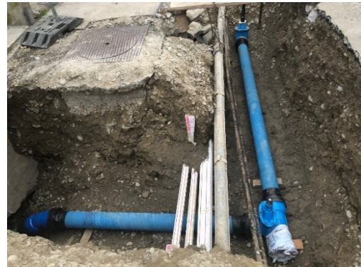
Leitungsbauten an der Hinterdorfstrasse
